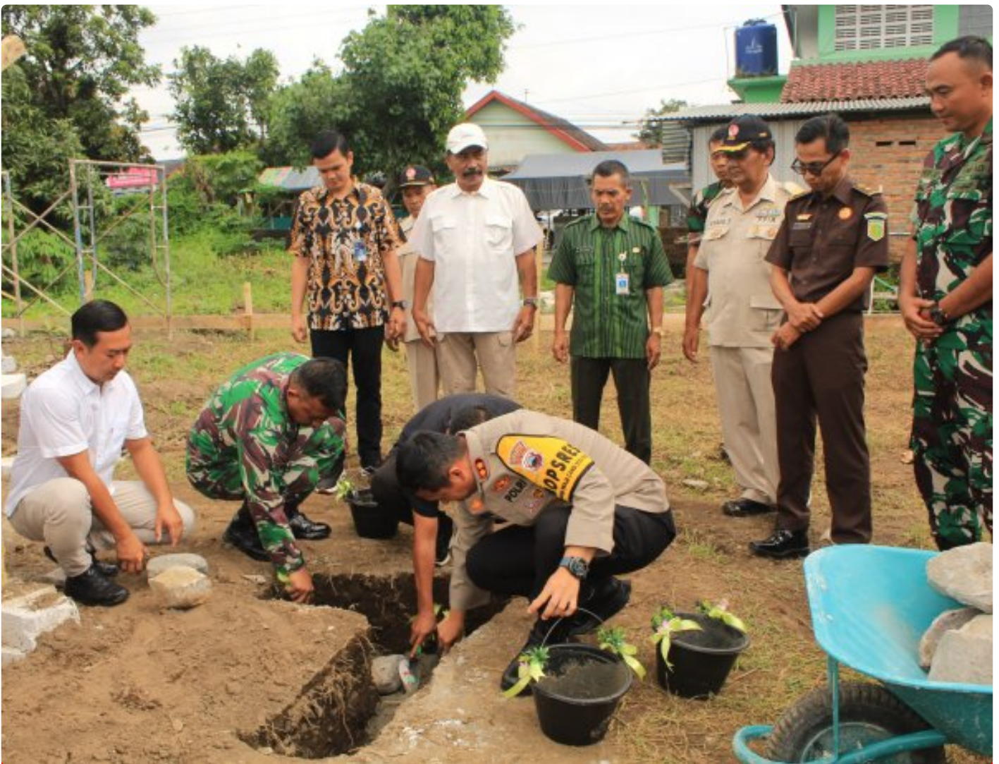
Kodim Klaten Fokus Program Pemenuhan Gizi dengan Pembangunan SPPG
